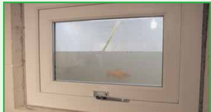
Hochwasserschutzfenster Neptun Outside: öffnet nach außen, Flügel steht in jeder Lage
