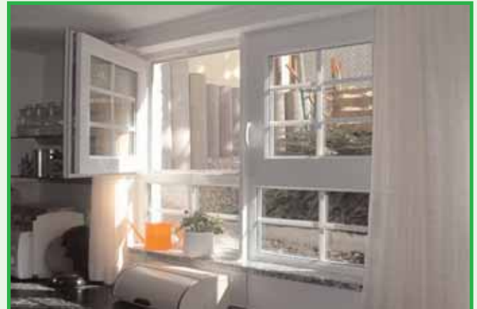
Drehkipfenster Nautilus Hybrid: öffnet nach innen, unten fix, ideal für Grundwasser
