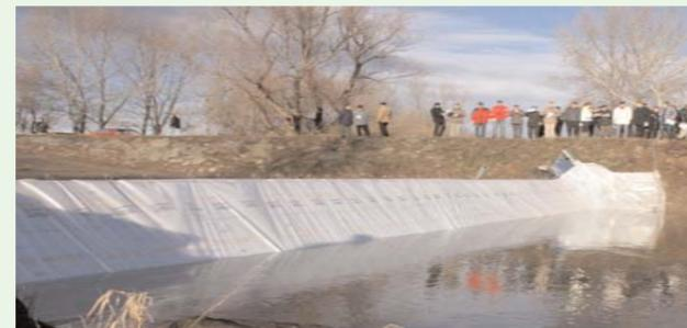
Der flexible Hochwasserdamm aus Stahl, Aluminium und Gewebeplane hält, was er verspricht!
