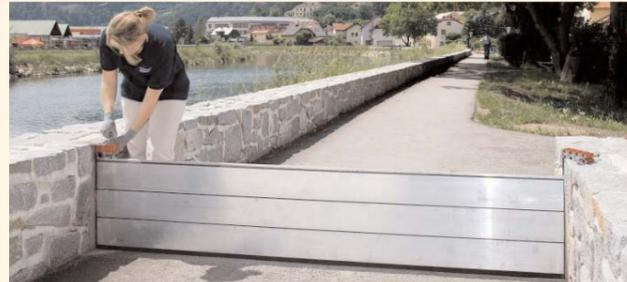
Moderne Aluminium-Dammbalkensysteme besitzt viele Vorteile. Bodenhülsen mit Bajonettverschluss erleichtern die Aufstellung von Mittelstützen, niedrige und schlanke Dammbalken sind relativ leicht und doch sehr stabil. Vor allem das Bajonettverschlussystem revolutioniert die Montage.
