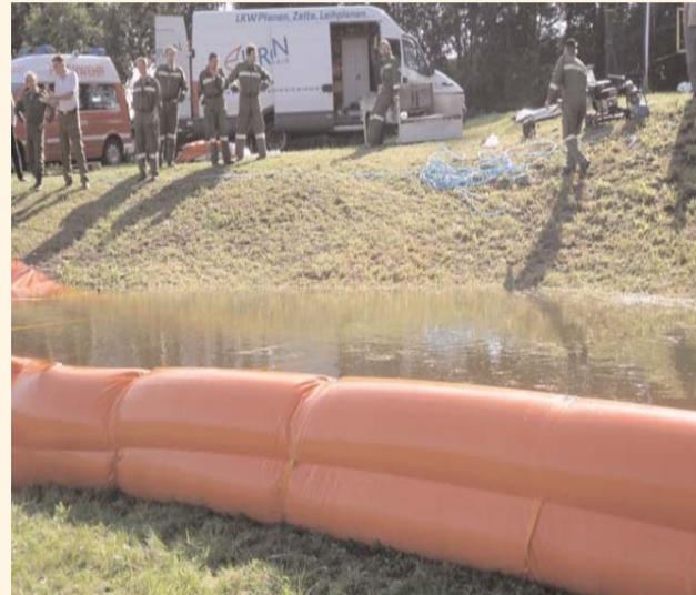
Dieses Hochwasserschutzsystem wurde nach dem Prinzip jener Swimmingpools entwickelt, bei denen ein luftgefüllter Schlauch durch den Auftrieb im ansteigenden Wasser aufschwimmt, wodurch sich die Barriere von selbst aufstellt. Dieser Hochwasserschutz ist sehr schnell einsatzbereit und preisgünstig. Dieses immer wieder verwendbare Planensystem dichtet hervorragend ab und wird mit Bodenankern im Untergrund befestigt.
