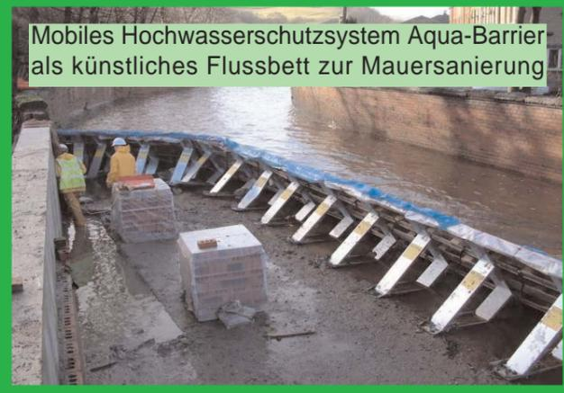
Mobiles Hochwasserschutzsystem Aqua-Barrier als künstliches Flussbett zur Mauersanierung
