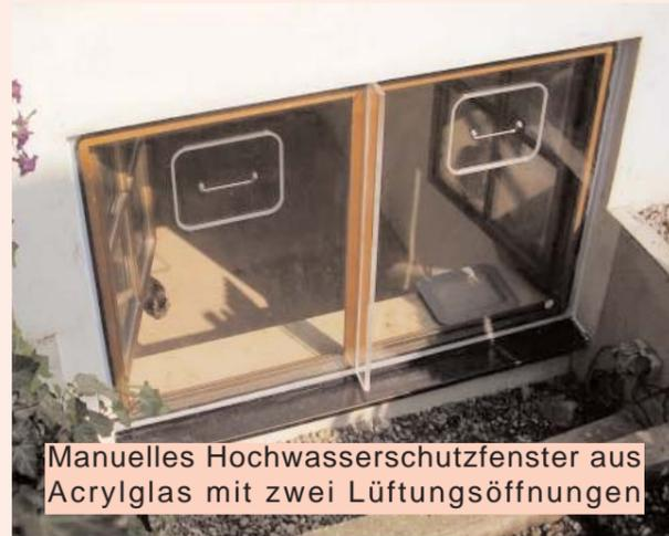
Manuelles Hochwasserschutzfenster aus Acrylglas mit zwei Lüftungsöffnungen
